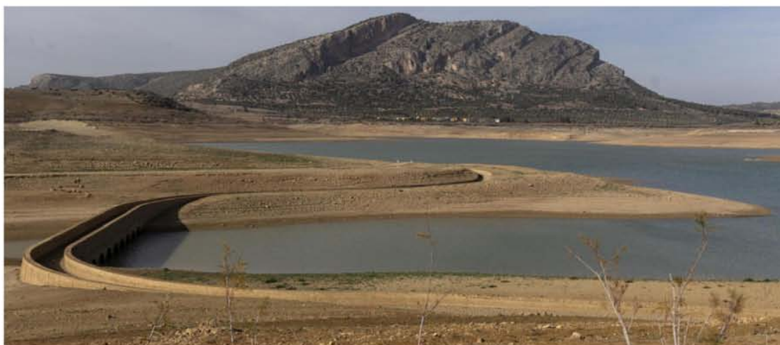
Vista del antiguo puente en el embalse de Guadalteba que han emergido al bajar drásticamente el nivel debido a la falta de lluvias
